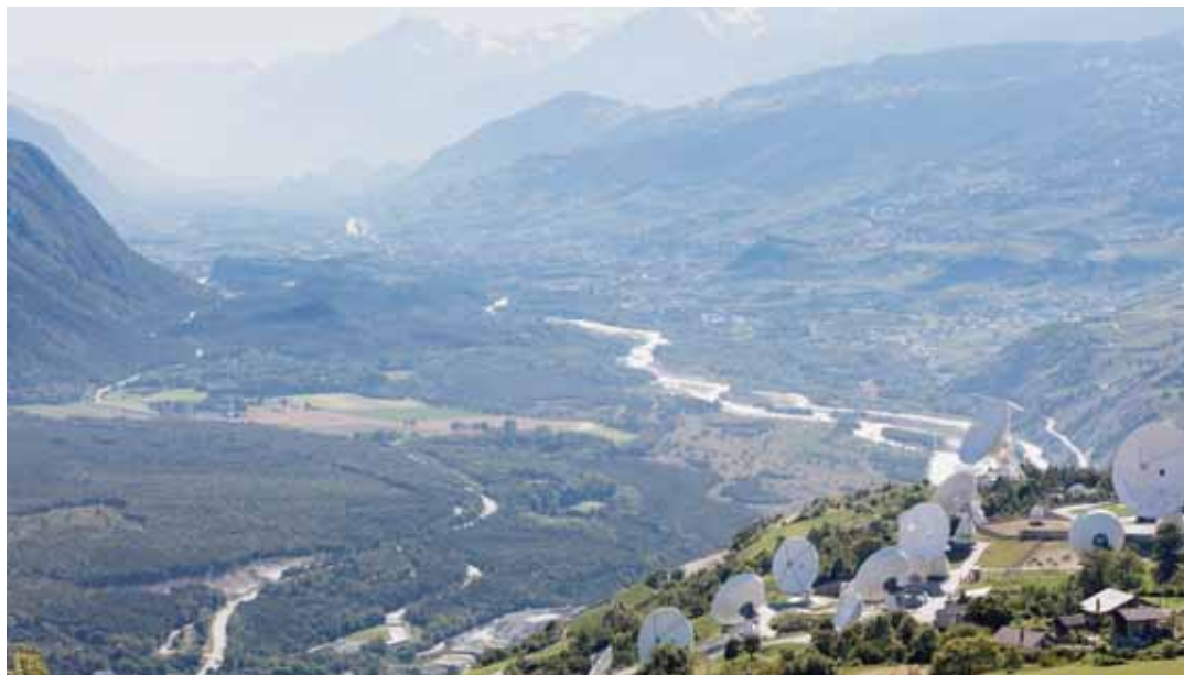
Les antennes paraboliques de la station terrienne de satellite Brentjong, dans le canton du Valais. Une partie des antennes est exploitée par le Département fédéral de la défense. KEYSTONE
