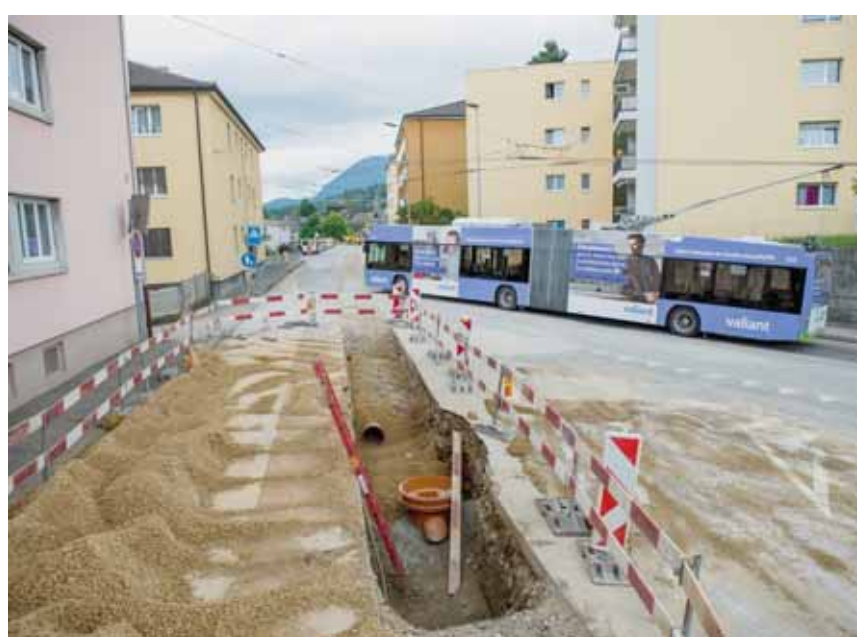
La rue des Préels est en travaux sur 470 mètres. LUCAS VUITEL
