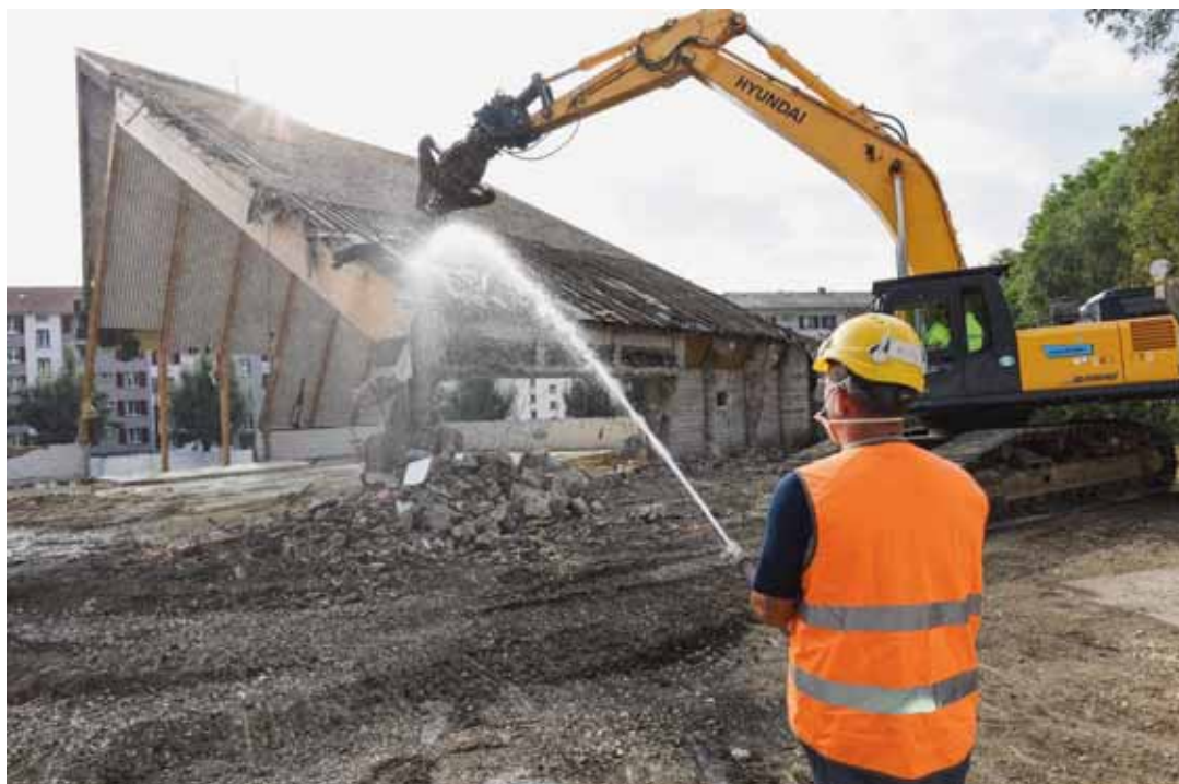
Hier matin, la dernière phase de déconstruction. Une heure plus tard, il ne restait rien. CHRISTIAN GALLEY
