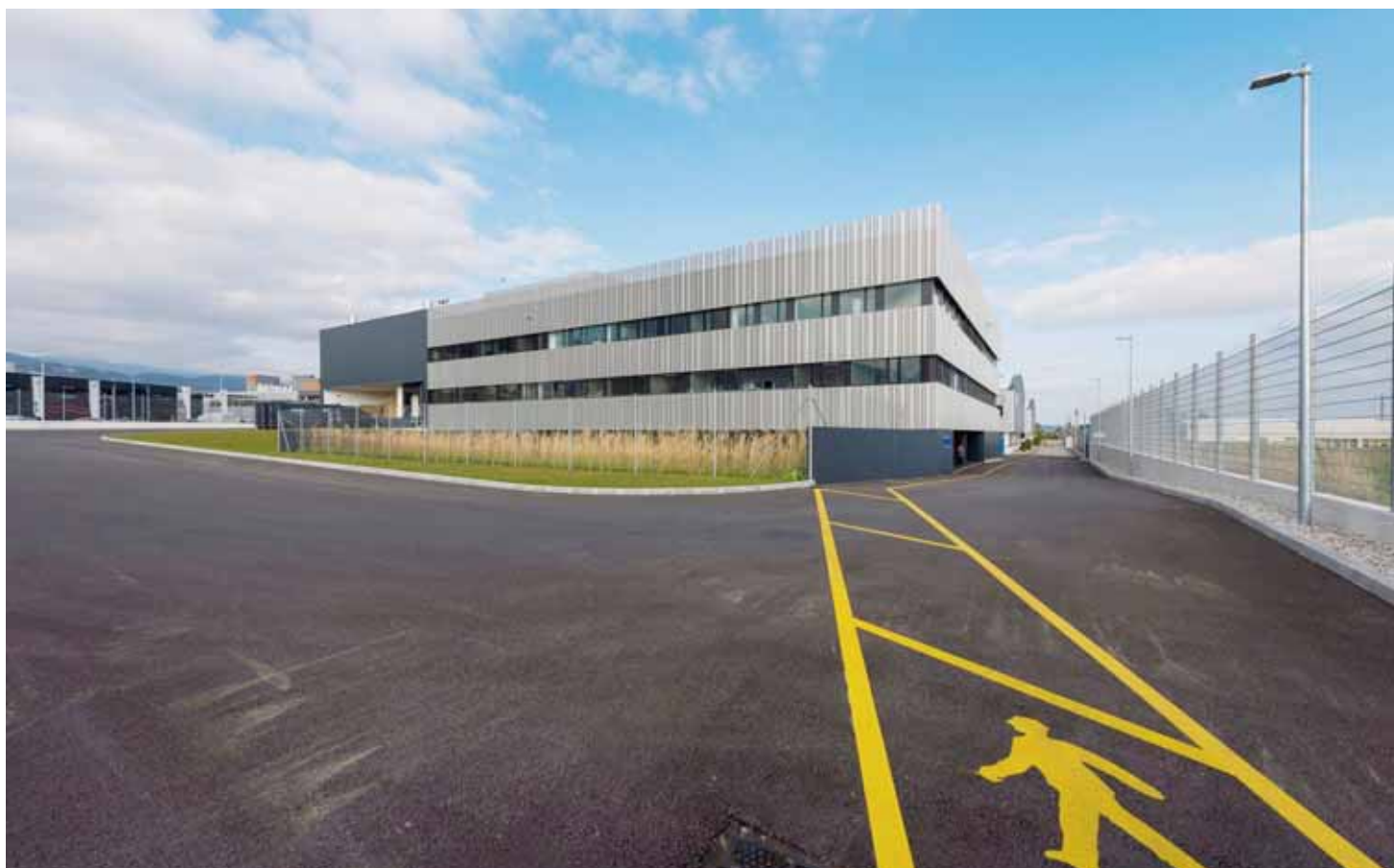
Complexe et très sécurisé, le nouveau bâtiment administratif et logistique de Metalor a été réalisé en deux ans. Cinq cents tonnes d'acier, hors structure, 200 portes (dont 120 coupe-feu) ou 3,5 km de conduites sous pression ont été nécessaires pour le réaliser. LUCAS VUITEL
