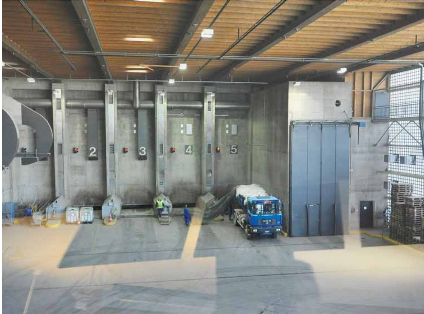
Le site chaux-de-fonnier d'incinération des déchets de Vadec, rue de l'Industrie 39. ARCHIVES RICHARD LEUENBERGER
