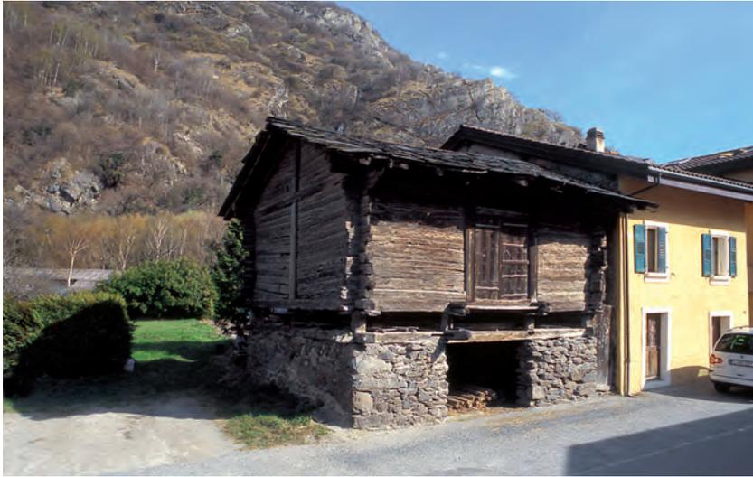
*Ce raccard traditionnel, posé sur ardoises, au-dessus d'un soubassement en pierre, est remarquable par ses proportions et son mode de construction. La plateforme et l'escalier d'accès ont été détruits par le temps et mériteraient d'être restaurés comme la toiture d'être contrôlée, pour éviter des dégâts irrémédiables. (Note de Christophe Mercier, architecte EPFL).*
