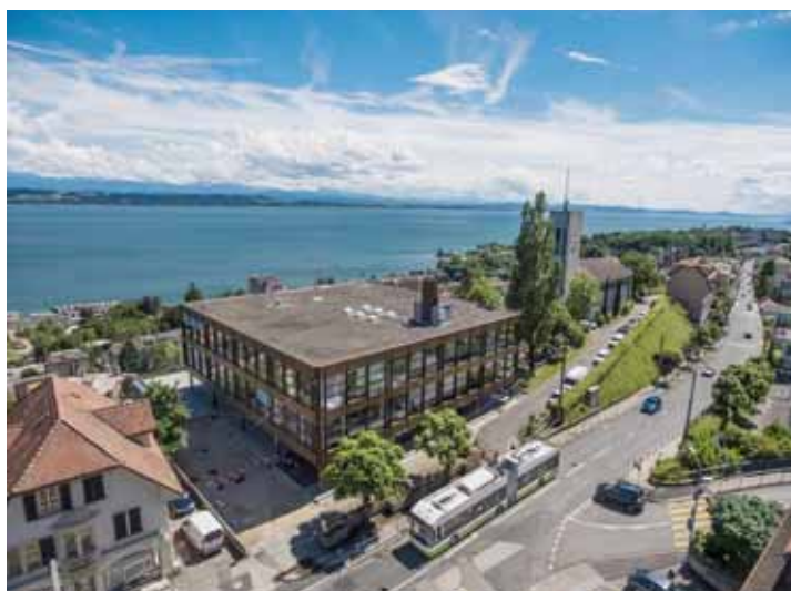
Le toit du collège du Crêt-du-Chêne sera recouvert de 400 panneaux solaires. STEFANO IORI
