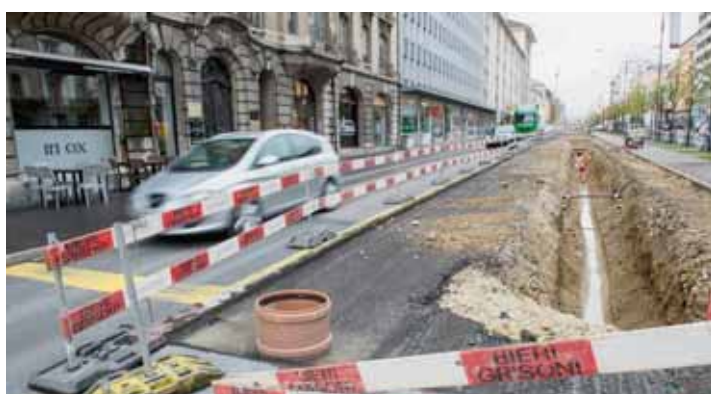
Terminé à droite (notre photo date du 12 mai), le chantier est maintenant passé à gauche, supprimant les places de parc sur le trottoir.
