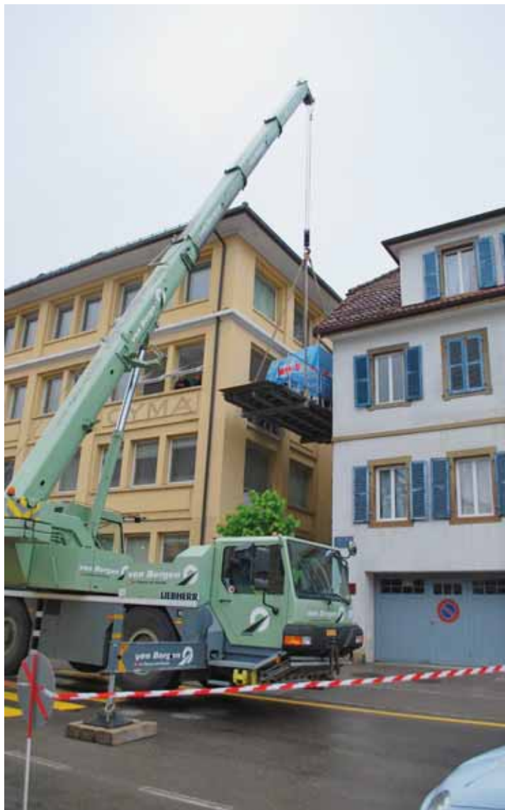
Une opération de précision: l'arrivée des machines dans les nouveaux ateliers d'Innotools. PIERRE-YVES SCHMID/EUROTECH
