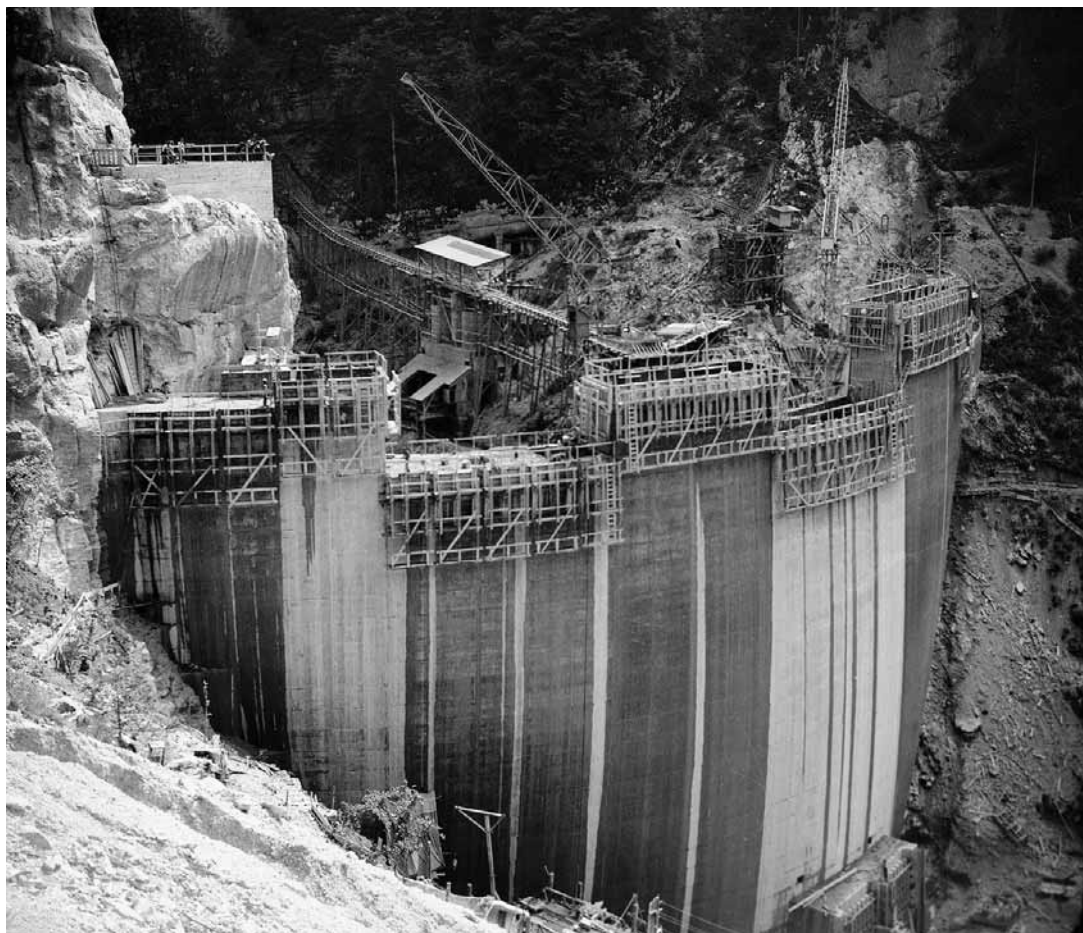
Le barrage du Châtelot, sur le Doubs, lors de sa construction au début des années 1950.
