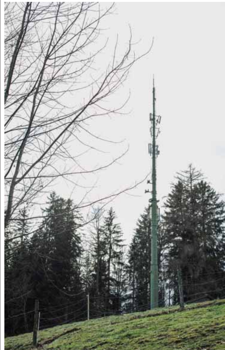
Là-haut sur la montagne du Châtelard se dresse l'antenne de Swisscom. Des améliorations lui permettront de mieux couvrir la région, les utilisateurs devraient le voir dès le début de l'automne. CHRISTIAN GALLEY
