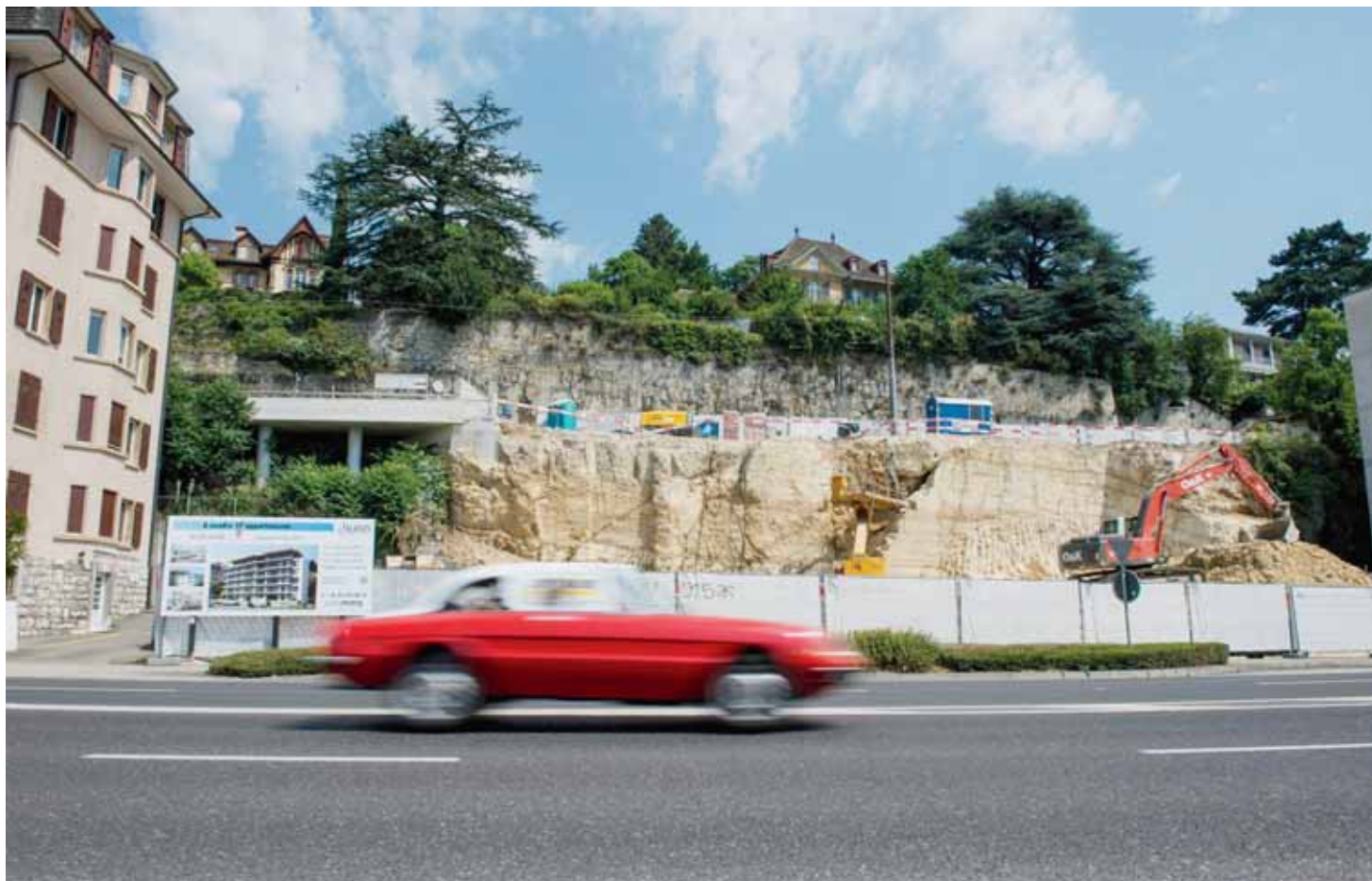
Route des Falaises, des bancs de pierre jaune sont «purges» avant la construction d'un immeuble. LUCAS VUITEL
