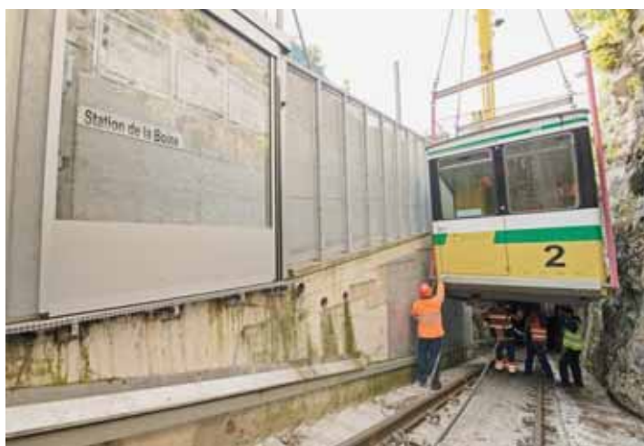
Les spécialistes fixent d'abord les tiges de métal sur lesquelles s'accrocheront les élingues de l'autogreue (à gauche). La voiture de 4,5 tonnes est ensuite soulevée doucement de sa voie.
