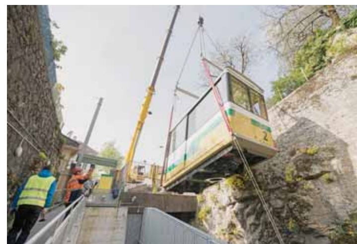
Les spécialistes fixent d'abord les tiges de métal sur lesquelles s'accrocheront les élingues de l'autogreue (à gauche). La voiture de 4,5 tonnes est ensuite soulevée doucement de sa voie.
