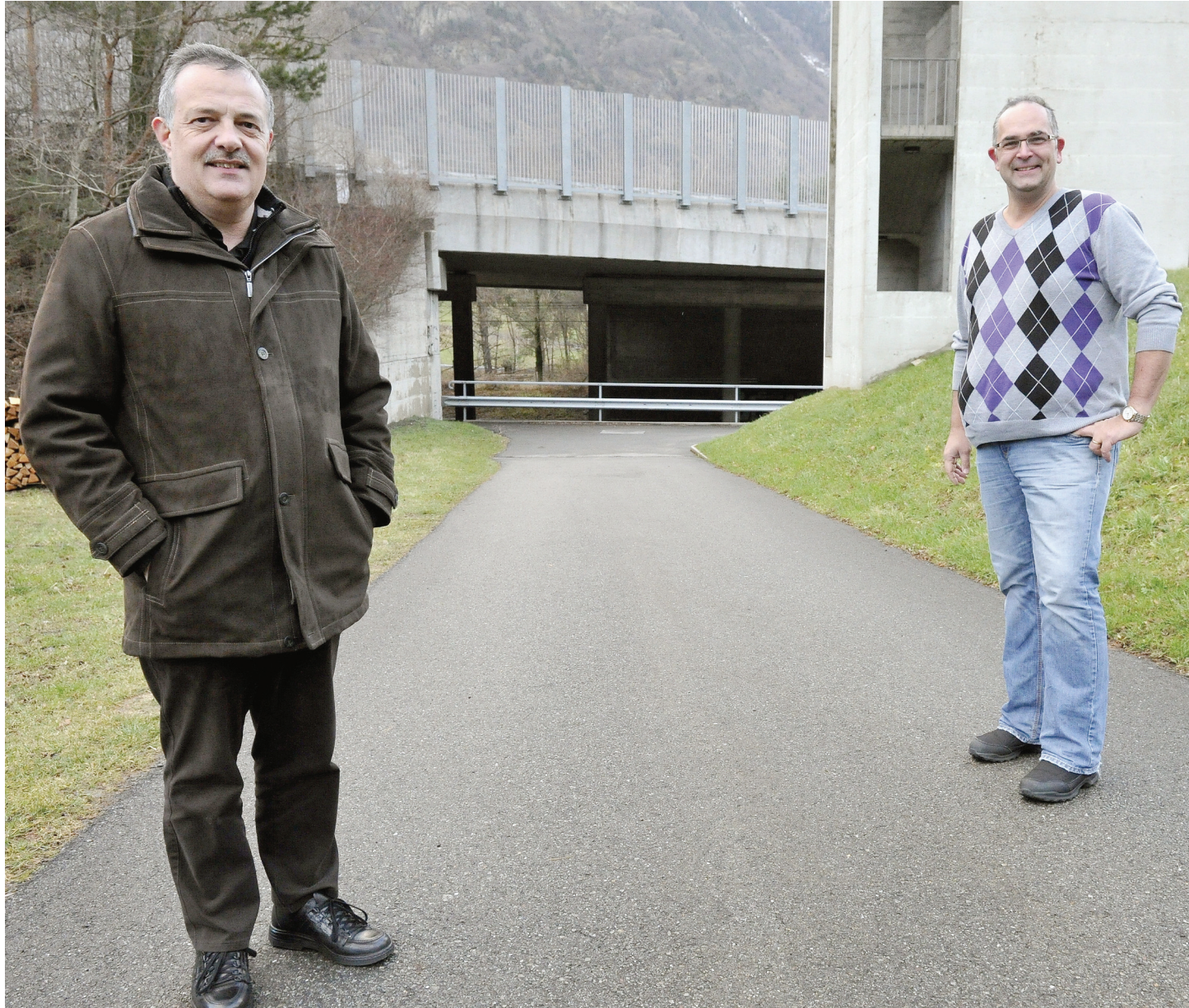
Le président Gilbert Jacquemoud et le municipal Lionel Pannatier s'inquiétaient du niveau des nuisances sonores près du lieu où le train passe sous le viaduc de l'autoroute, qui forme une caisse de résonance. Les mesures ont montré qu'elles sont inférieures aux valeurs limites. ANDRÉE-NOËLLE POT/FA
