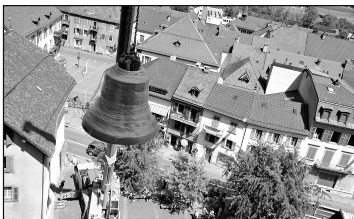
La nouvelle Trinitas s'élève au-dessus du bourg plus tard que prévu. Et il faudra encore plusieurs jours pour en terminer l'installation.
