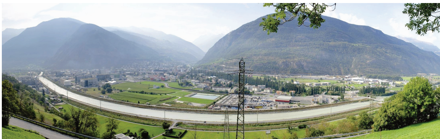
Le site de la Lonza, à Viège, est désormais protégé des crues du Rhône. La photo du haut montre le lit du Rhône avant les travaux. Ceux-ci sont peu spectaculaires. Le gabarit du fleuve a été augmenté et les berges renforcées. JOSEF FUX
