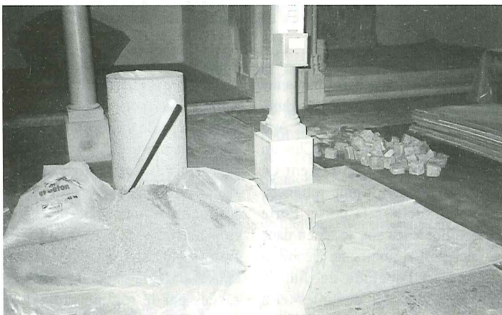
Automne 1999 - Saint-Germain en chantier
