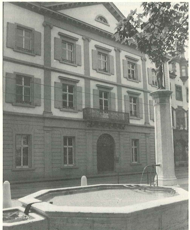
Façade du Formonterhof
