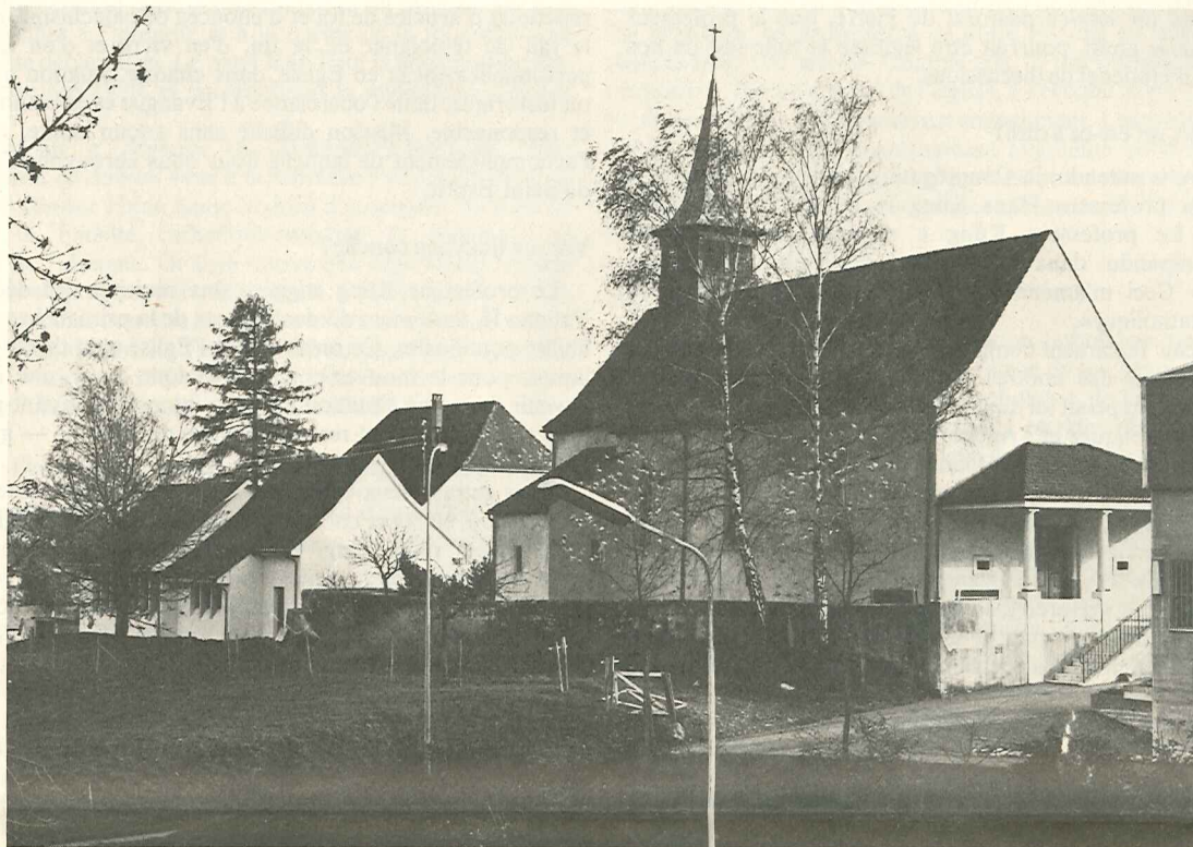
L'église et le centre paroissial de Starrkirch
