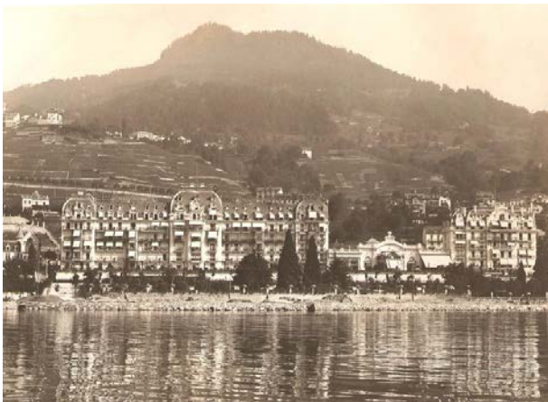
Figure 37. Le Montreux-Palace avec les quais en plein travaux. Source: Antoinette Zürcher via Roger Bornand
