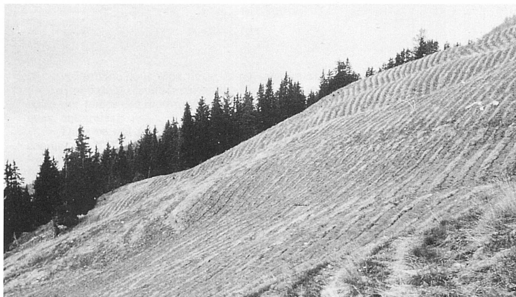
Aménagement de bermes (petites terrasses) contre le rampement de la neige. On y procède aux nouveaux boisements (alpage d'Aire sur Conthey)
