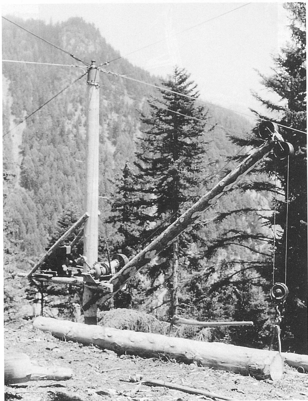
Installation ingénieuse d'une grue tournante, montée en 1958 à Chamoson, pour le chargement des grumes sur camion. (Elle nous rappelle les mécanismes déjà utilisés au Moyen-Age)
