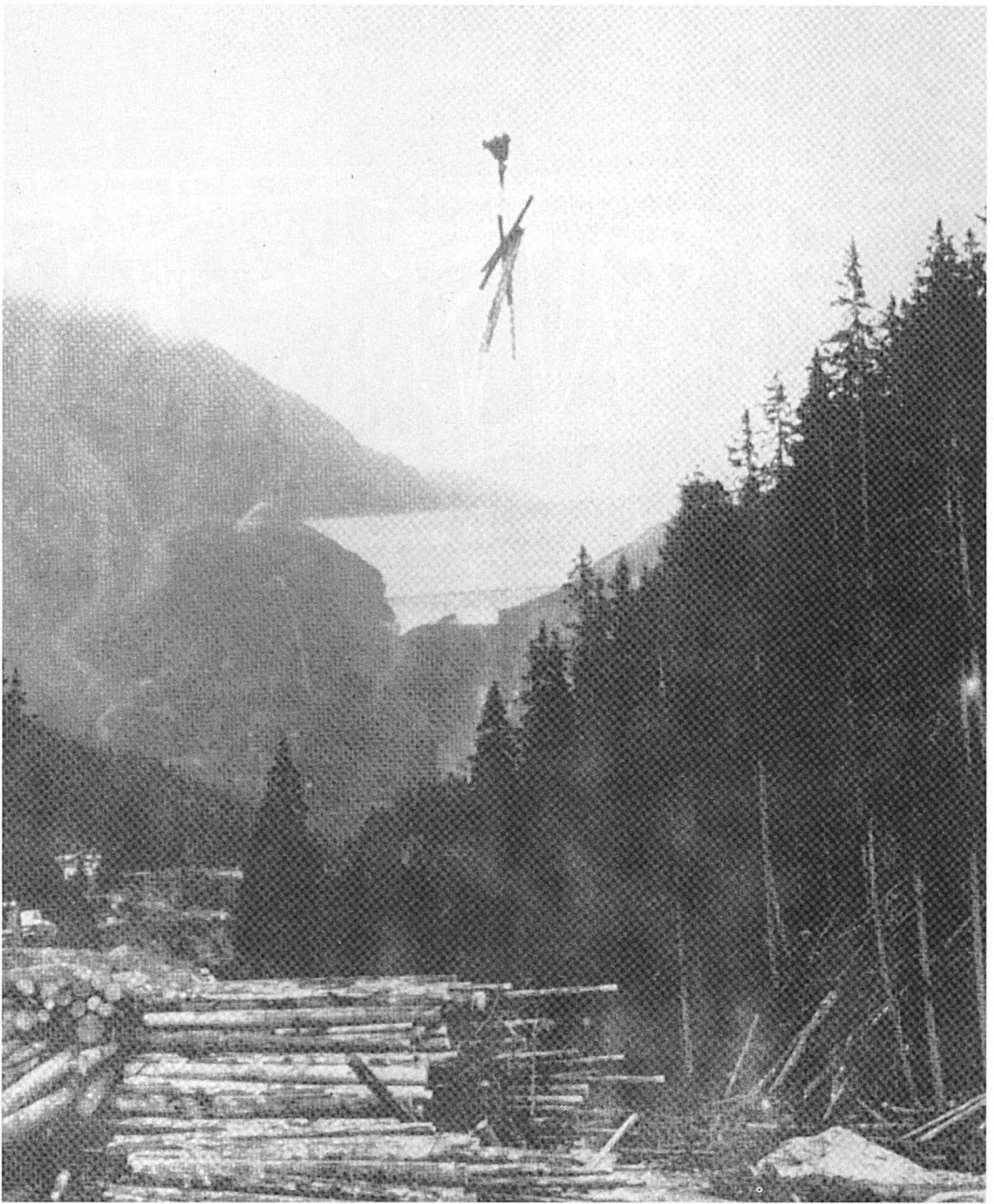
Câblage de bois au moyen du câble à grue en 1971. A l'arrière-plan, le barrage de Grande Dixence.
