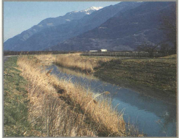
PHOTO 7 – Talus du canal du Syndicat, avec tronçons non fauchés. Martigny, avril 2003. – PHOTO EMMANUEL REVAZ
