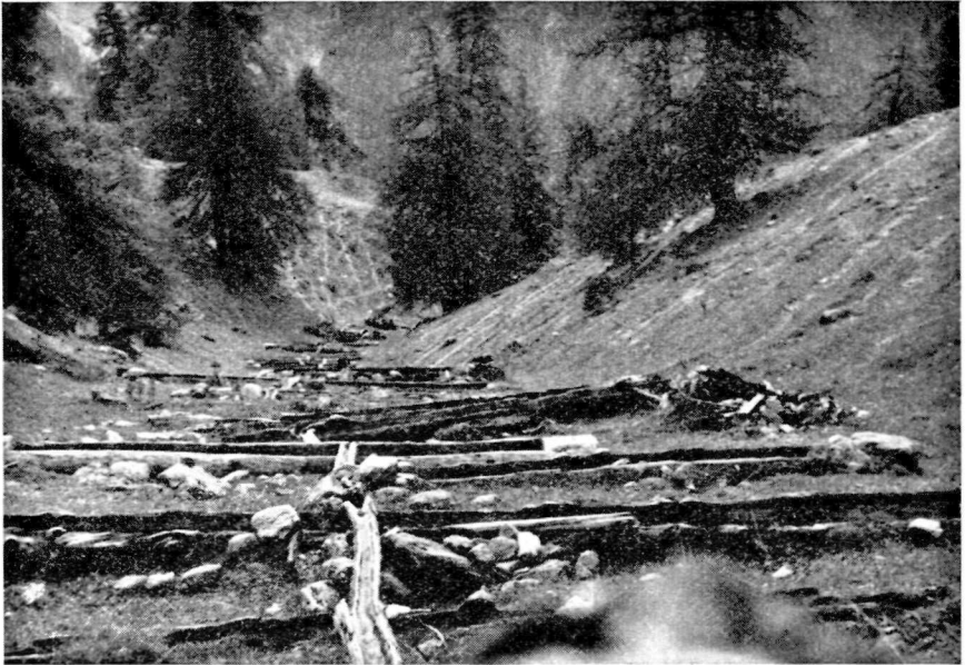
Fig. 1 - Anciens bassins à Balavaux
