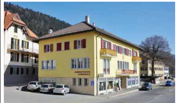
L'aménagement du cabinet médical de premier recours dans le bâtiment de l'ex-administration communale de Fontainemelon, avenue Robert, est en stand-by. ARCHIVES RICHARD LEUENBERGER
