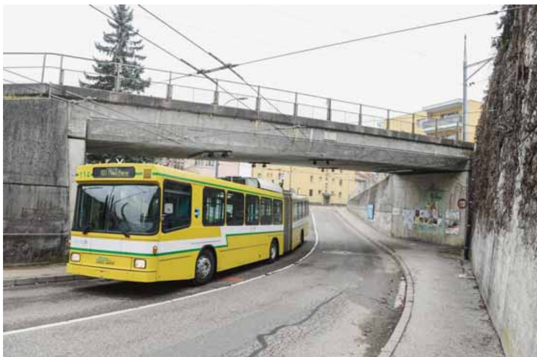
La passerelle aurait été construite parallèlement au pont CFF de la rue des Préels. CHRISTIAN GALLEY
