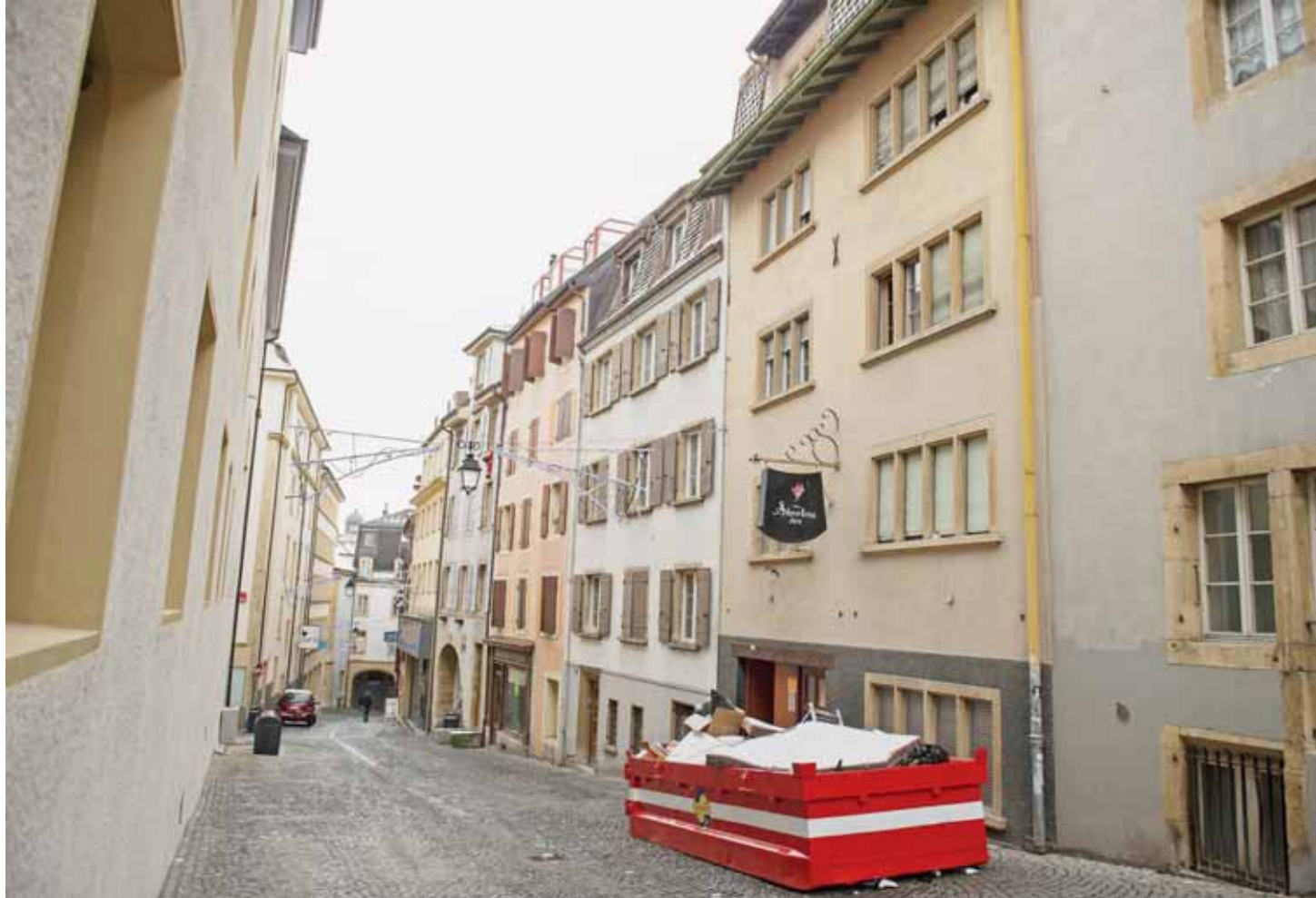
Depuis la rue, l'immeuble touché par l'incendie ne présente pas de traces visibles du sinistre. Une benne sert, semble-t-il, à l'évacuation de déchets en tous genres. DAVID MARCHON
