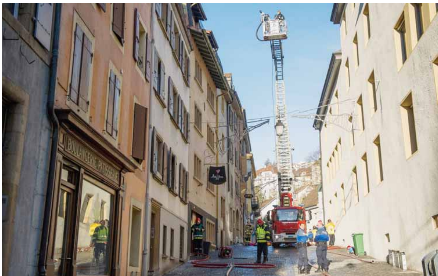
L'incendie de la rue des Fausses-Brayes était sous contrôle peu avant neuf heures du matin. LUCAS VUITEL
