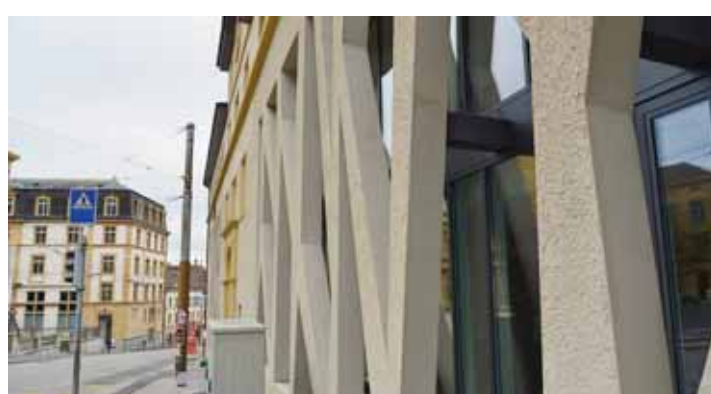
Comme toujours avec l'architecture, il y a ceux, nombreux, qui trouvent que les ouvertures créées dans les façades, ainsi que les immenses croisillons, sont magnifiques... et il y a les autres. RICHARD LEUENBERGER
