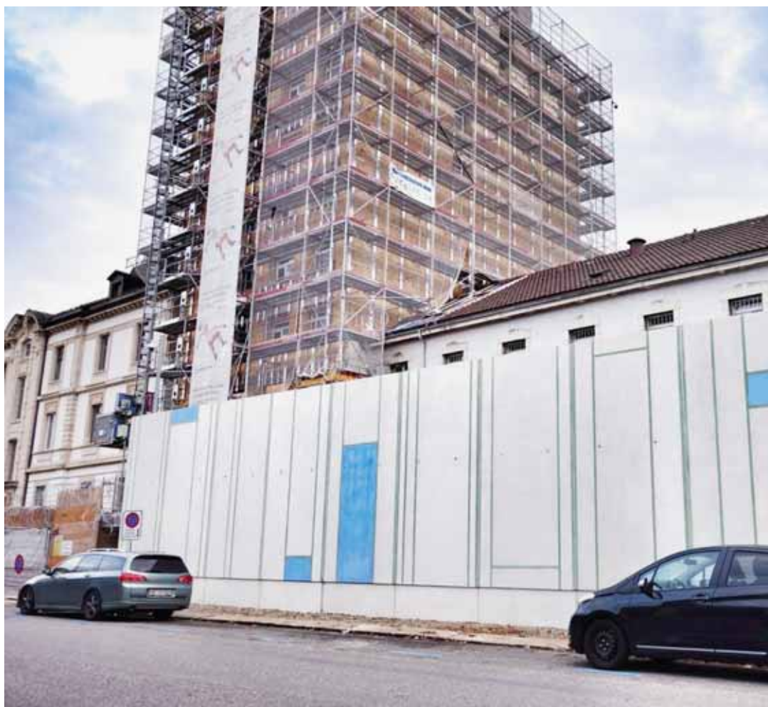
La prison de la Promenade à La Chaux-de-Fonds est en rénovation depuis 2010. LUCIEN CHRISTEN
