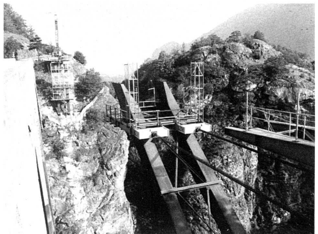
Le 17 août 1993, les béquilles d'acier sont en place: le tablier approche
