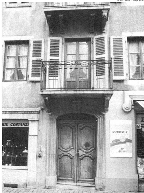
9. Grand-Rue, exemples de balcons à dalles sculptées
