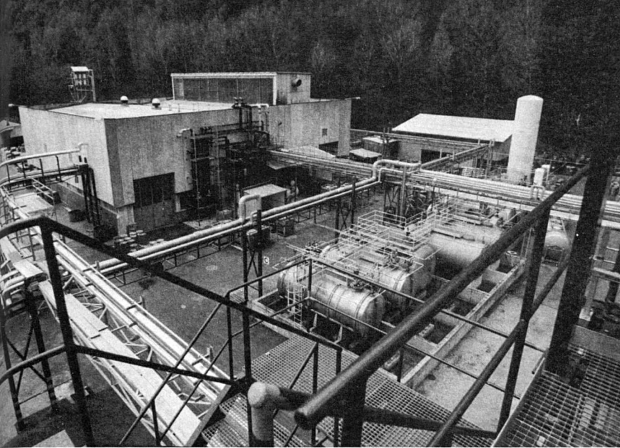
Très bon voisinage avec la forêt (usine sud)
