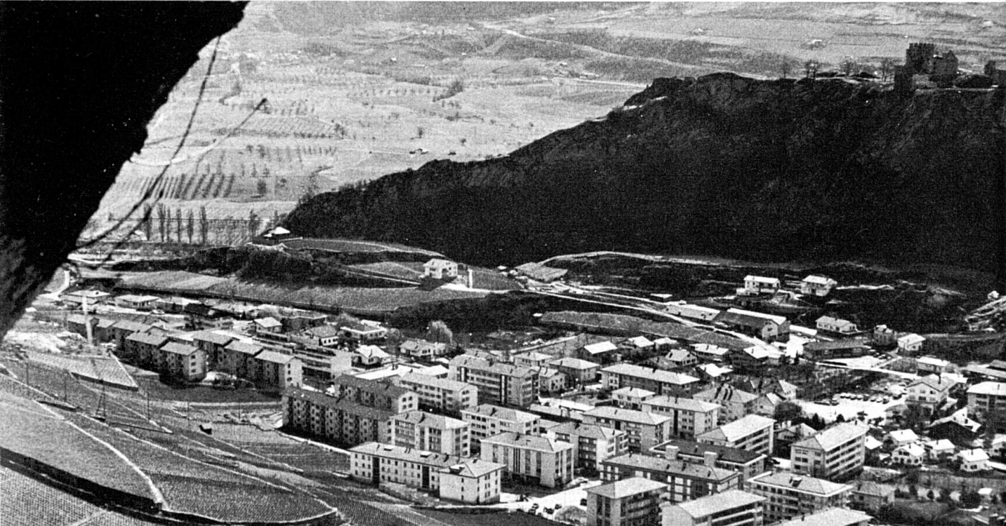
Sion-hors-les-Murs : le quartier de Platta
