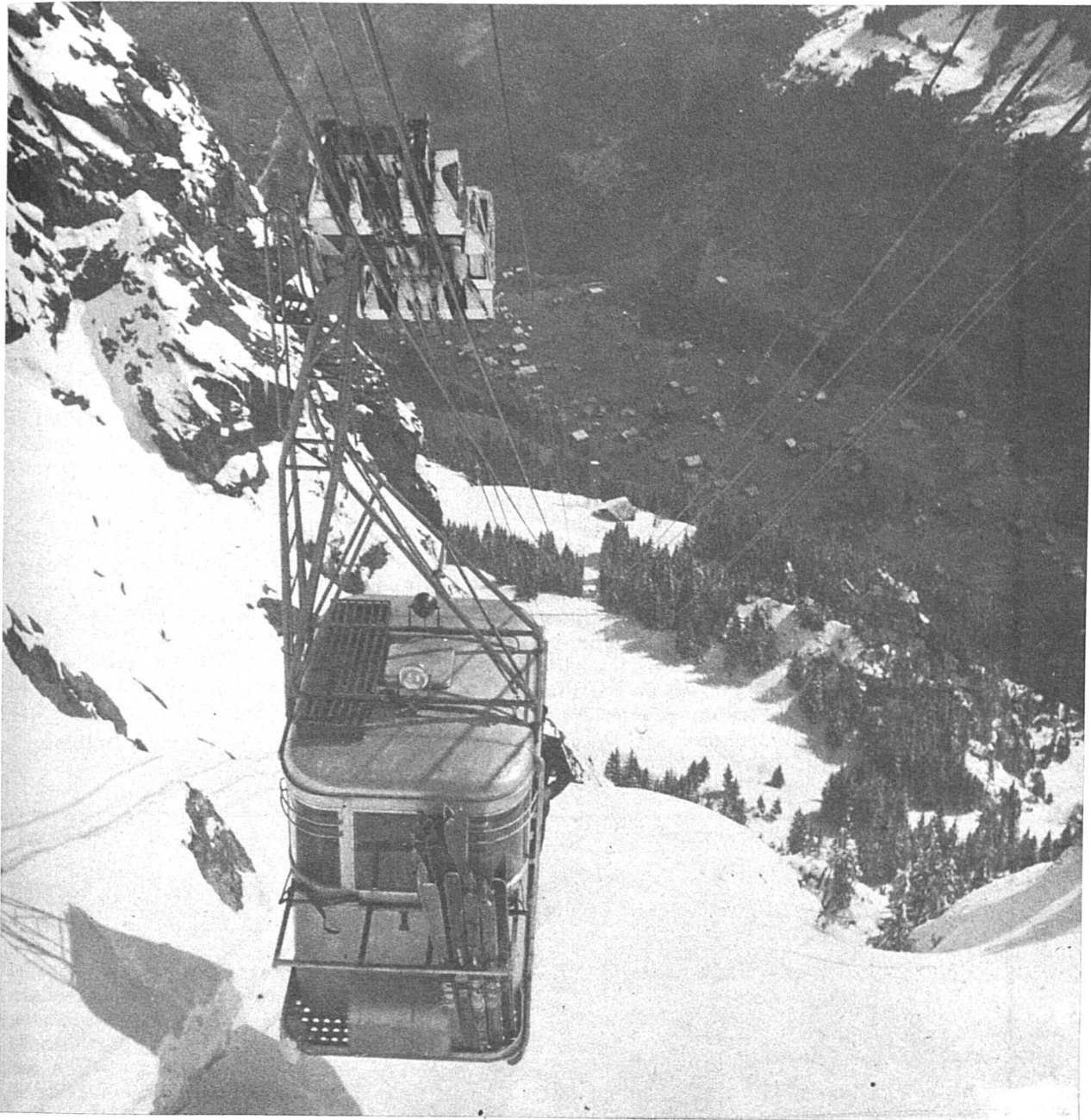
Le rapide et vertigineux téléphérique qui, de la station de Champéry — que l'on aperçoit en bas — conduit aux majestueux champs de ski de Planachaux.
