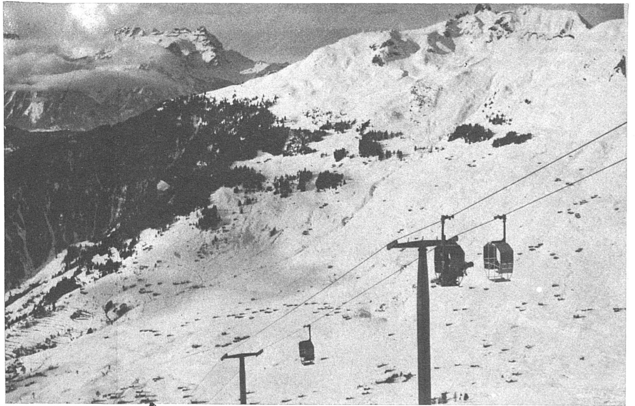
Le télésiège de Verbier-Médran qui débite 400 personnes à l'heure et s'étend sur une longueur de 1800 m. avec une dénivellation de 680 mètres.
