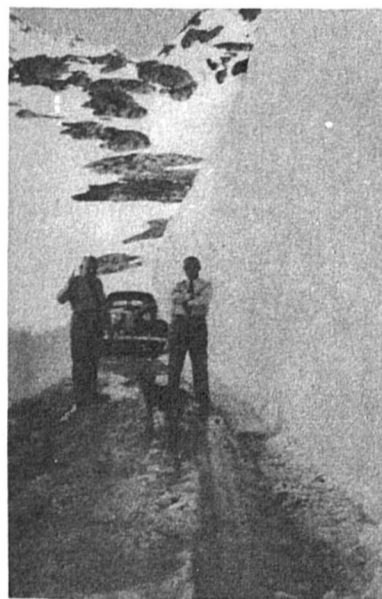
Le sol a été enfin atteint. Encore la tranchée ne permet-elle que le passage à sens unique et les chutes de neige tardives obligent parfois à recommencer ! En dépit de ces mesures, d'ailleurs fort onéreuses, le trafic routier Suisse-Italie demeure paralysé durant de longs mois.
