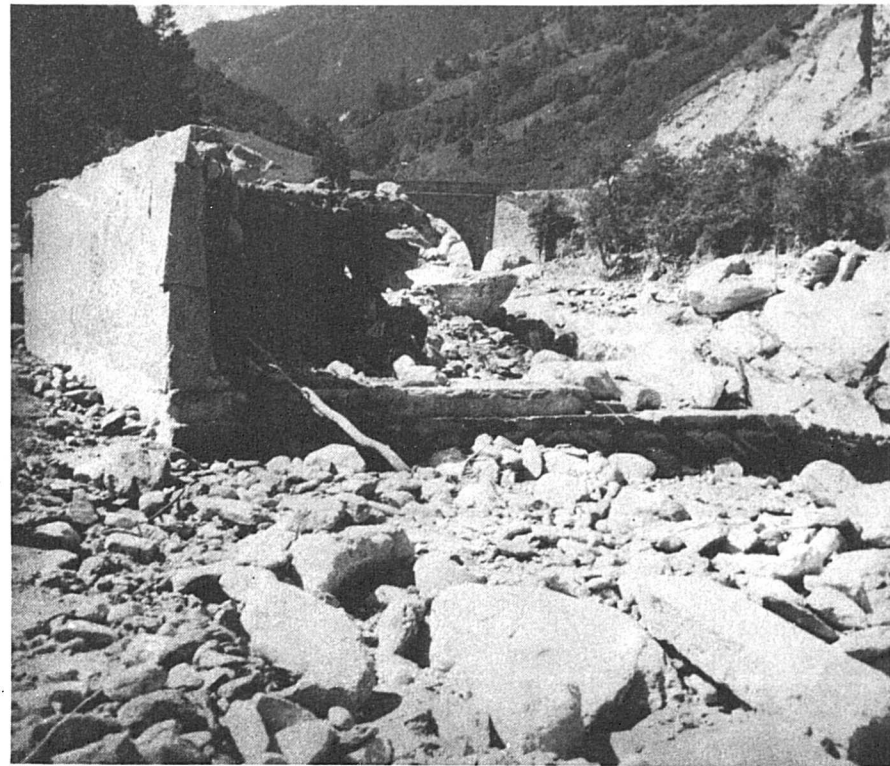
Ce qui reste d'une maison en construction au bord du lit de la Dixence; les flots ont tout emporté.
