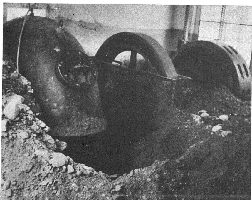
L'intérieur de l'usine du Sauterot, avec ses machines enterrées dans le limon.
