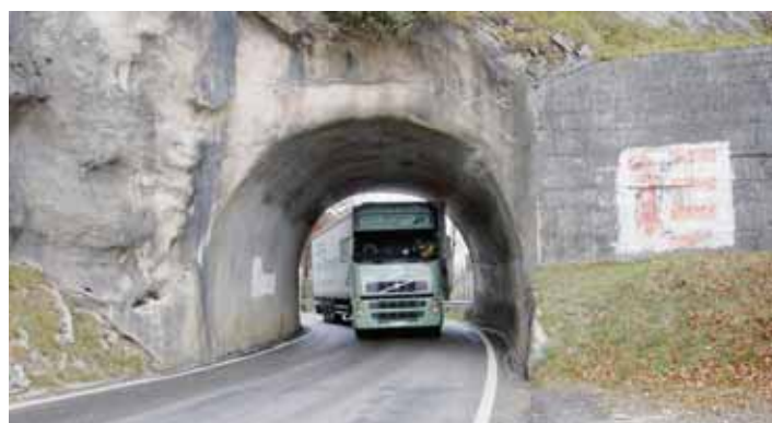
Le tunnel de la Roche est emprunté quotidiennement par plus de 4000 véhicules, dont une centaine de camions. ARCHIVES BIST-DANIÈLE LUDWIG
