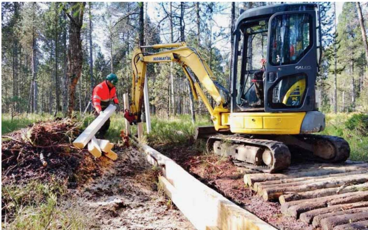
De longs pieux en bois sont enfoncés dans la tourbière afin de créer une palissade, visant à retenir l'eau jusqu'ici captée par les nombreux drains creusés au 17<sup>e</sup> siècle. La construction d'une palissade dure environ une semaine. LUCIEN CHRISTEN
