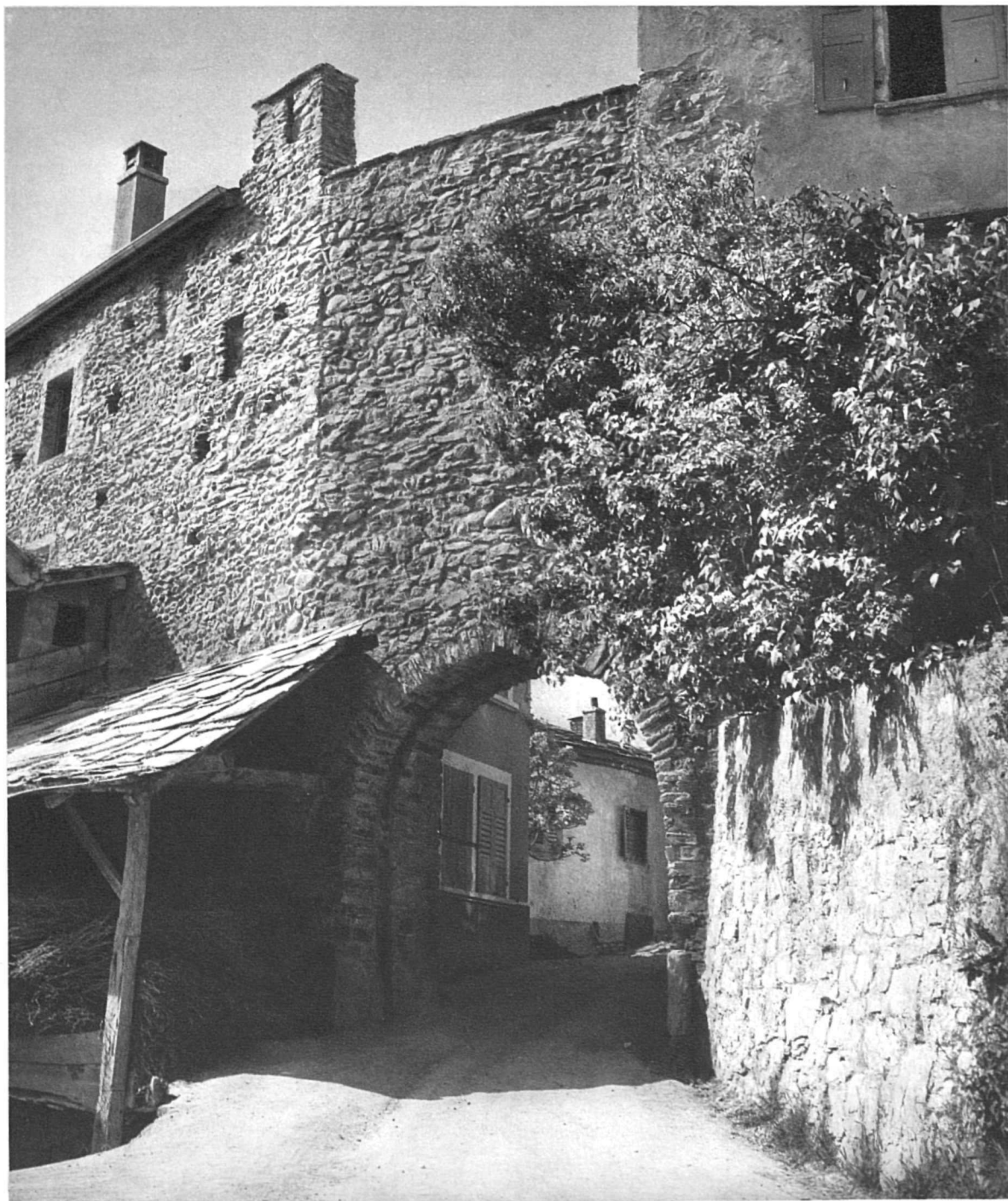
La porte de Leytron. Sur les montants intérieurs, on voit encore la longue rainure verticale dans laquelle on faisait mouvoir la herse.
