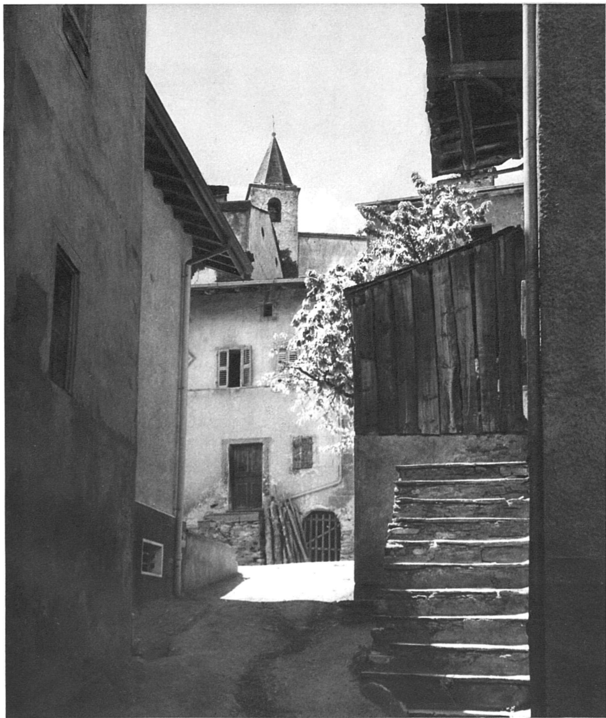
Ruelle dans le bourg au-dessous de l'église.
