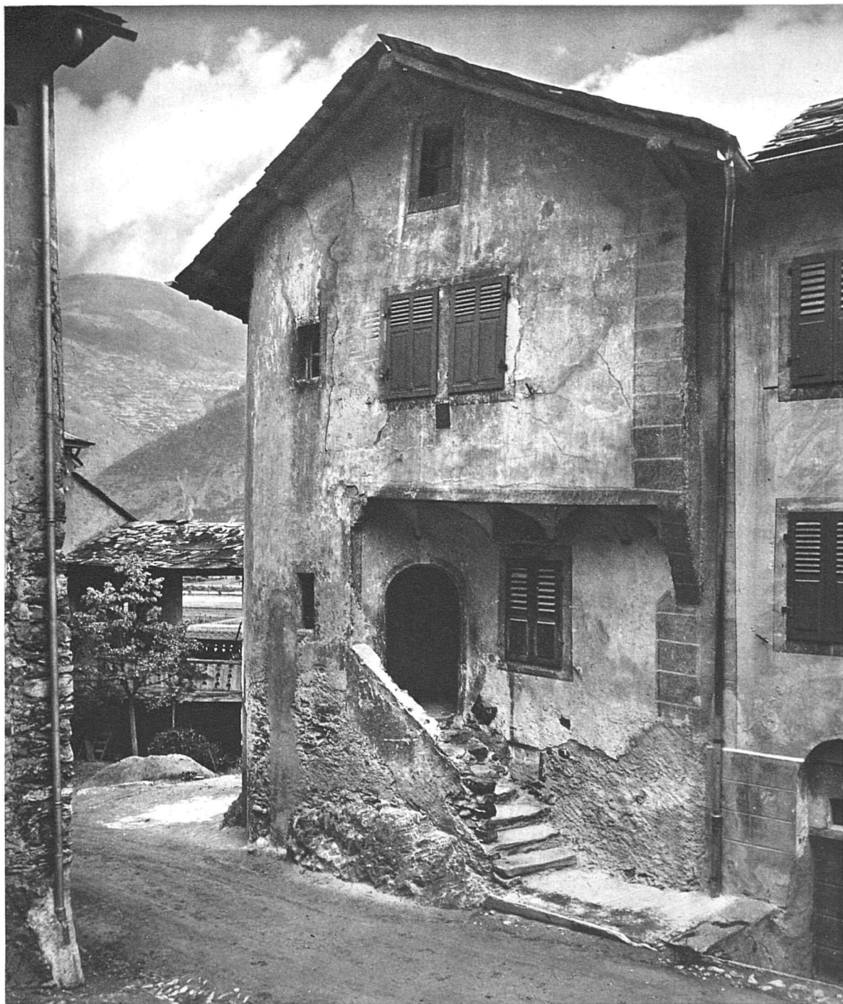
Curieuse maison dont la façade, au-dessus de l'escalier à vis ouvert sur la chaussée, présente une partie saillante soutenue par un demi-berceau aux arêtes fort élégantes.
