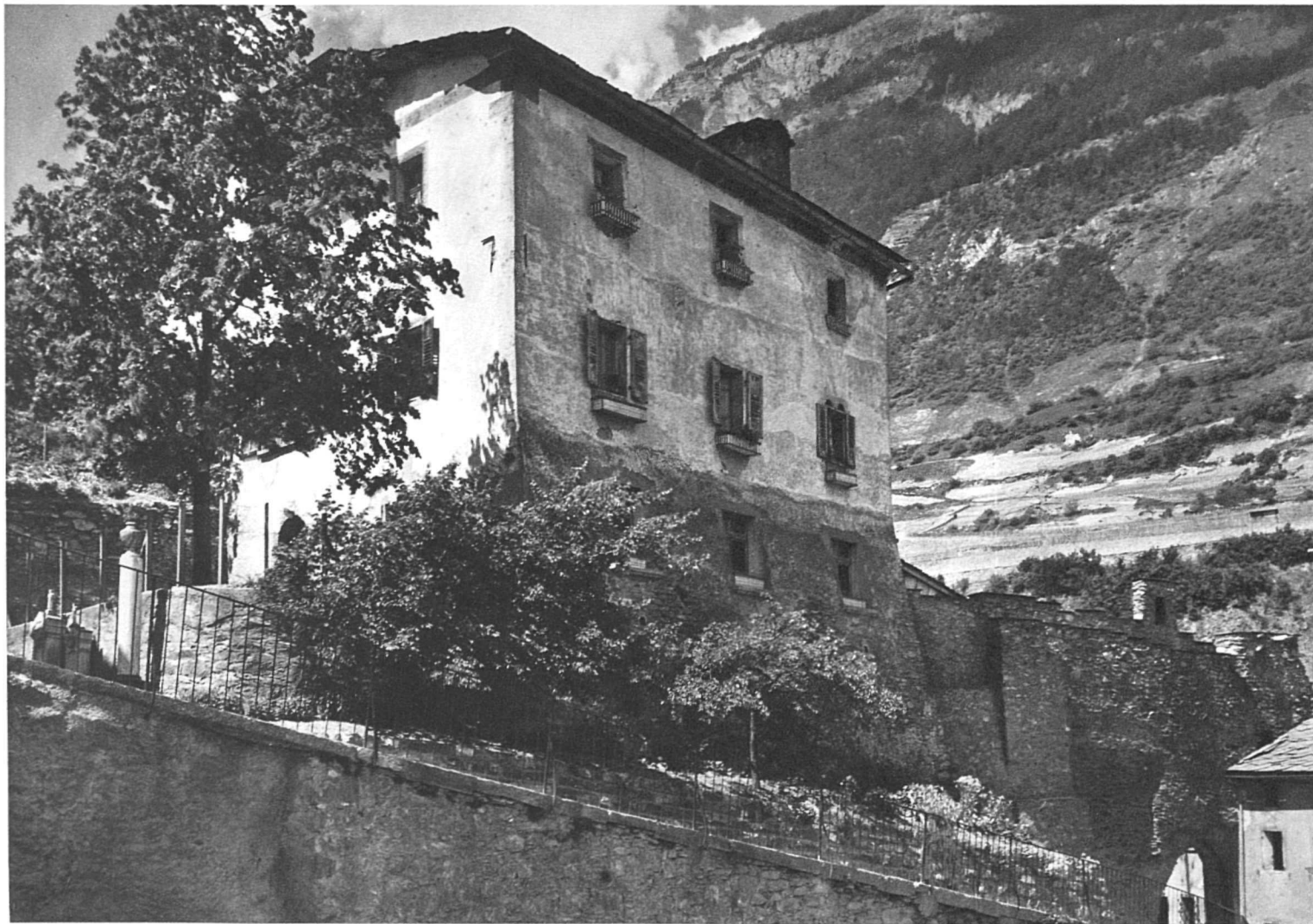
Le bâtiment de la cure (ancien hospice de Saint-Jacques) avec ses énormes murs de soutènement, se dresse au-dessus de la rampe qui conduit à l'église.
