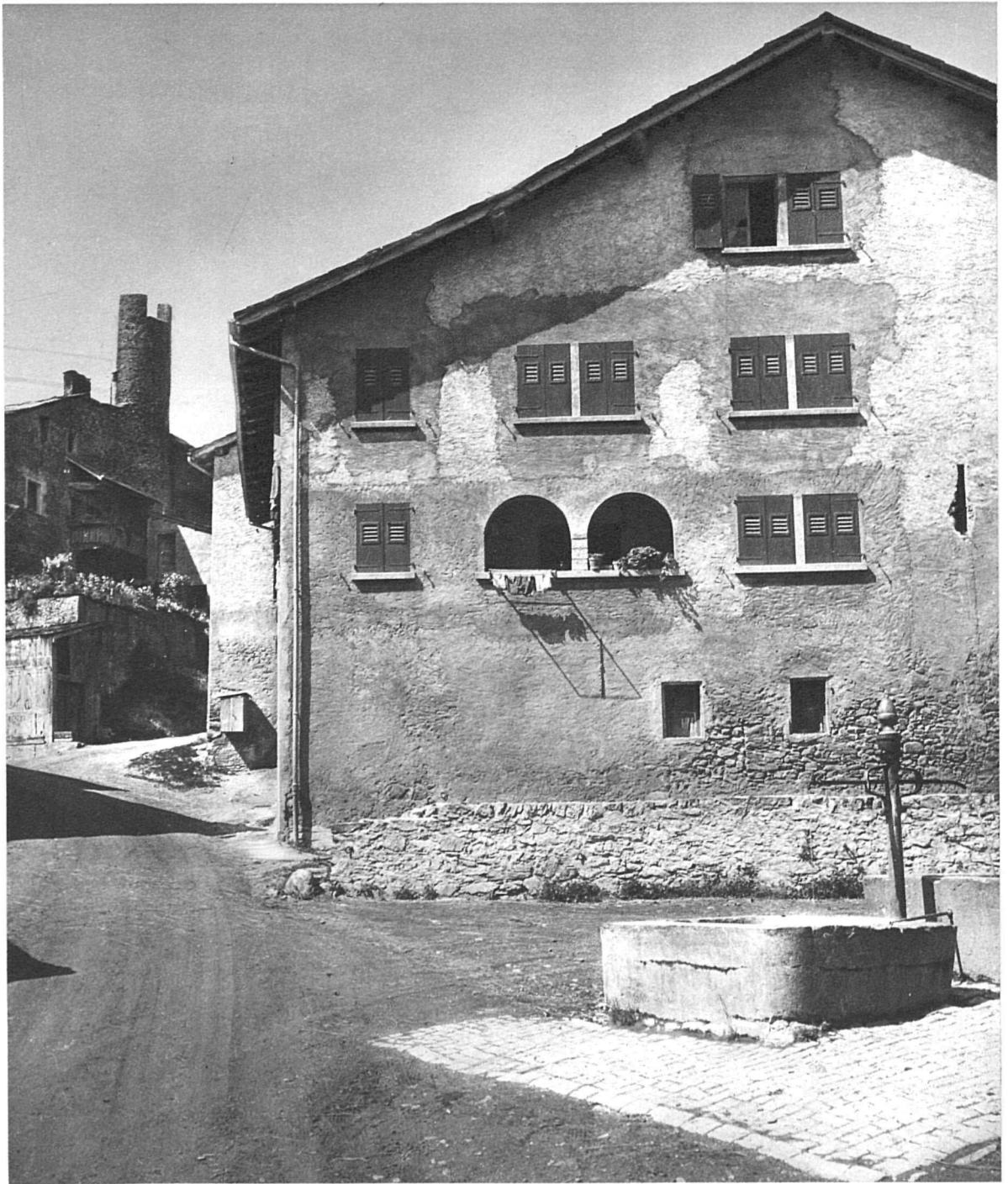
Maison discrètement restaurée.
