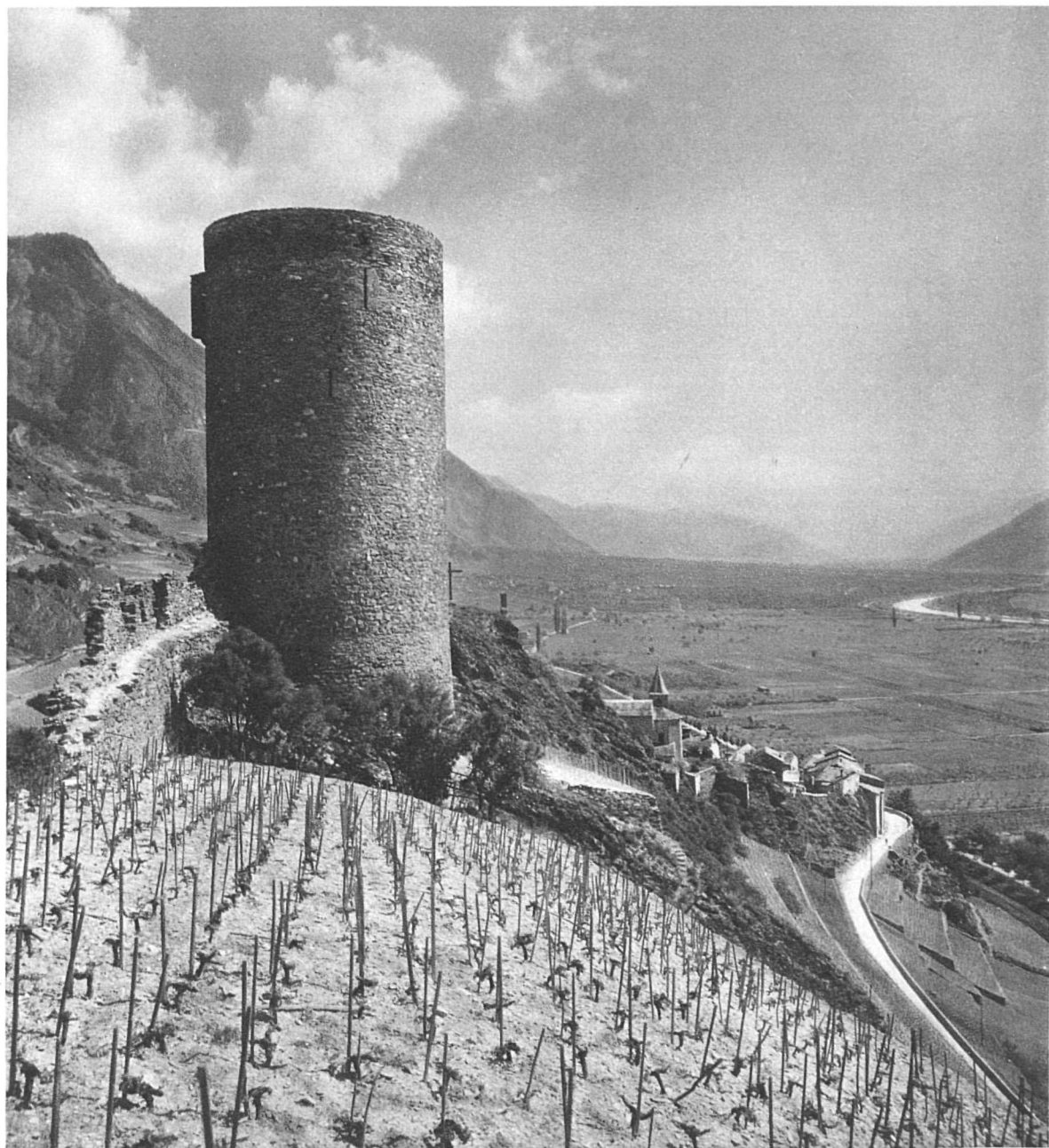
Le donjon, vu du front ouest, avec la vallée du Rhône en amont de Saillon.
