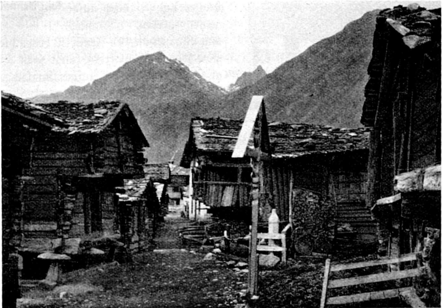
Fig. 74. Dorfgasse mit Stadeln und Ställen in Rippel.
