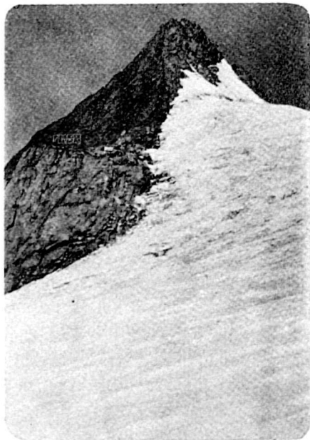
Fig. 41. Steigerhütte am Anengrat (im Bau).
