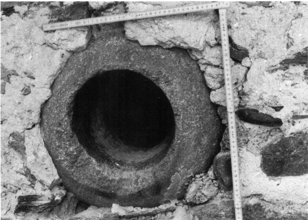
Fig. 4 - Liddes-Les Moulins: l'oeillard d'un rebaté aère et éclaire la boulangerie. (Cliché IRRI, P.-L. Pelet)
