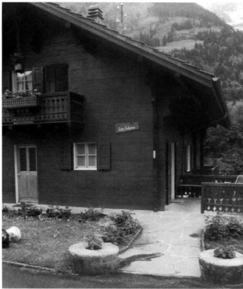
Fig. 24 - Val-d'Illiez / Le Play: deux rebatés marquent l'entrée du dallage conduisant au chalet «Les Tulipes».
