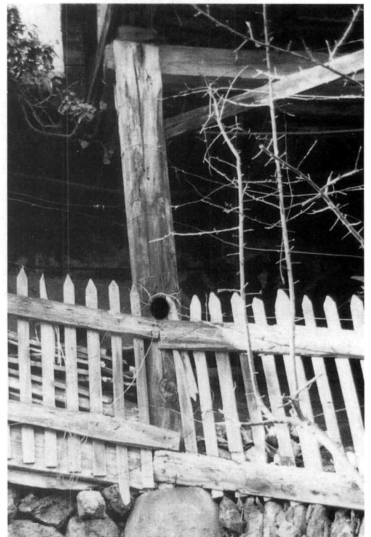
Fig. 6 - Leuk: un rebaté supporte l'ancien arbre de sa ribe, utilisé comme soutien d'un avant-toit. Le trou par où passait l'axe horizontal est visible entre les pointes de la barrière.
