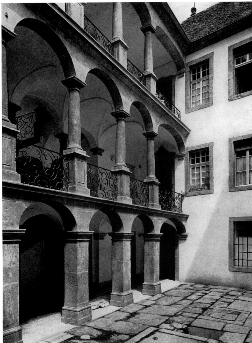
Maison familiale. Cour intérieure et galeries.
