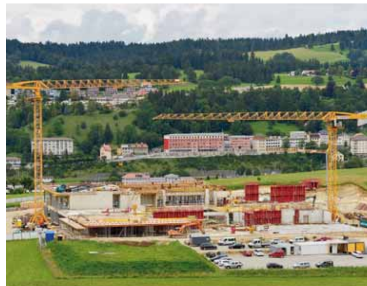
Travaux en cours aux Saignoles pour Cartier-Joallerie.
