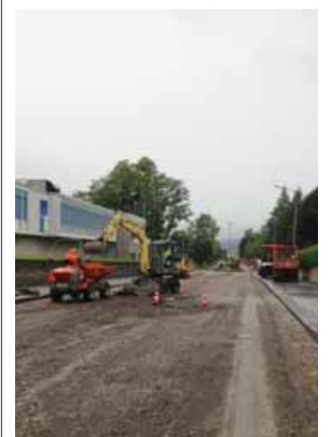
En friche encore à fin juillet, le tronçon jusqu'au giratoire du Grenier est maintenant terminé.
