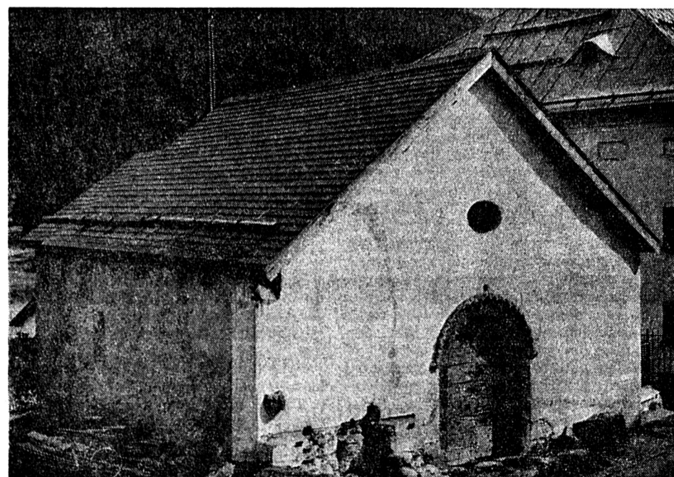
La chapelle San Sebastian à Zuoz (XIII e siècle), avant et après la nouvelle couverture avec des ardoises noires en amiant-ciment éternit. Le matériau de couverture a été posé à la manière de la couverture de bardeaux en pierre.
