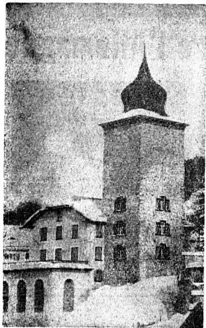
La tour Planta à Susch, Engadine, a été recouverte autrefois de bardeaux en bois. Aujourd'hui, la coupole se présente avec une nouvelle couverture du toit en ardoises noires, en amiant-ciment éternit, aux angles rognés.
