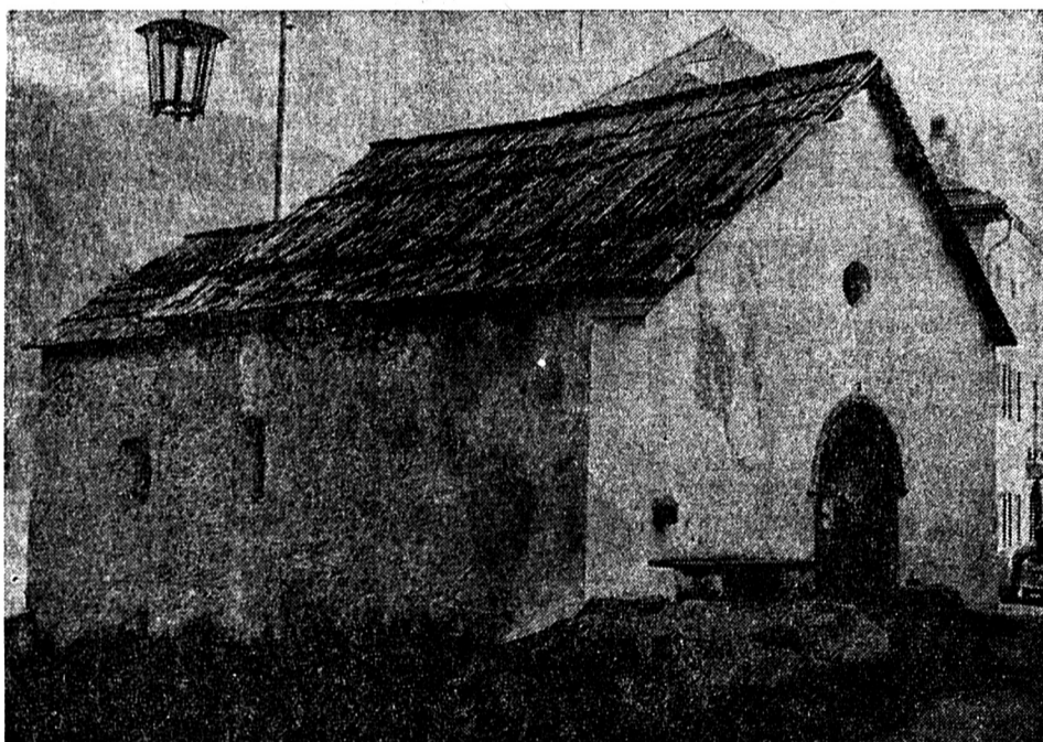
La chapelle San Sebastian à Zuoz (XIII e siècle), avant et après la nouvelle couverture avec des ardoises noires en amiant-ciment éternit. Le matériau de couverture a été posé à la manière de la couverture de bardeaux en pierre.
