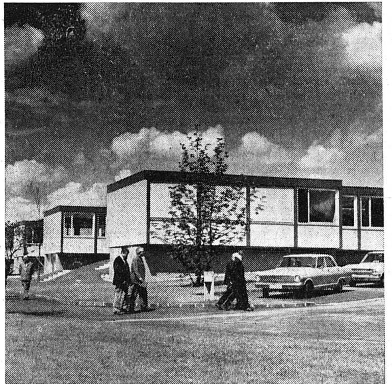
Le manque d'écoles et les longs délais de construction appartiendront bientôt au passé. En effet, une maison de Villmergen (AG) a mis au point un système d'éléments préfabriqués qui baisse les dépenses. En outre, le nombre d'étages est presque illimité et les constructions peuvent être adaptées aux conditions topographiques. Notre photo montre le séminaire argovien de Wohlen, composé de quatre bâtiments, construit en préfabriqué en 99 jours.
