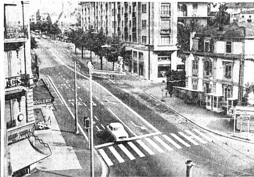
Vue de l'avenue de Rumine prise du carrefour de Georgette. A noter, en premier plan: une caméra de télévision sur mât de 10 m. avec porte à faux.
