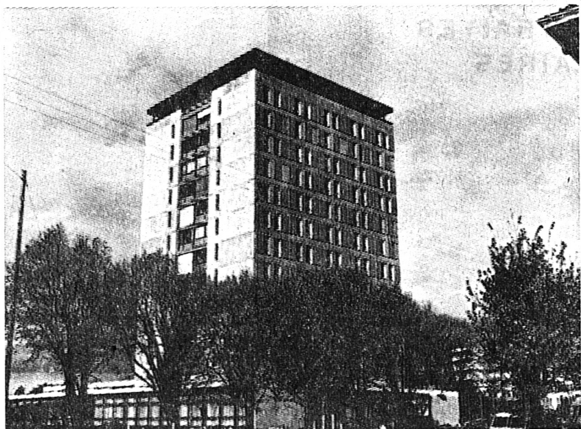
Tour de 12 étages, élancée et élégante, la nouvelle Ecole d'infirmiers et d'infirmières est une splendide réalisation
