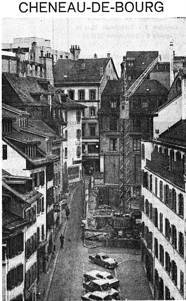
RÉALISATION RADICALE... une grue, quelques limaces
