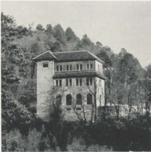
Valangines: vue actuelle de la station de transformation.
