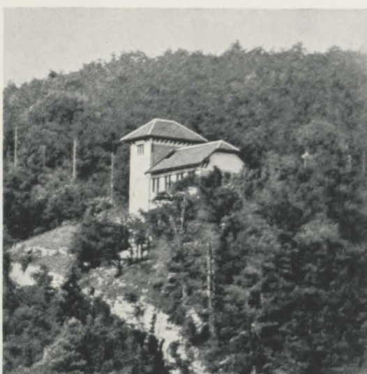
Valangines : station principale de transformation (avant les travaux d'agrandissement).
