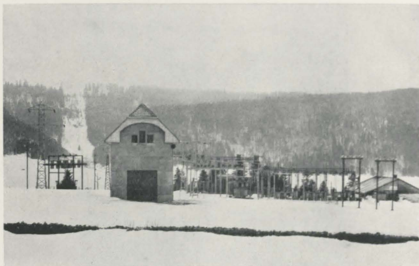
Corbatière: station principale de transformation et de distribution.
