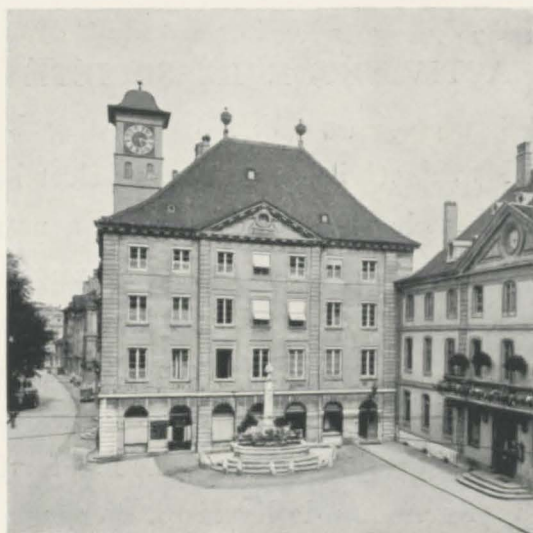
Troisième siège de la société : Hôtel des Services industriels.
