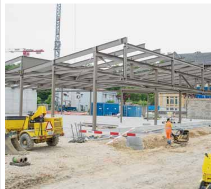
La pollution au Pré-Landry a une nouvelle fois été évoquée. Sur place, la construction d'un magasin Migros avance. DAVID MARCHON
