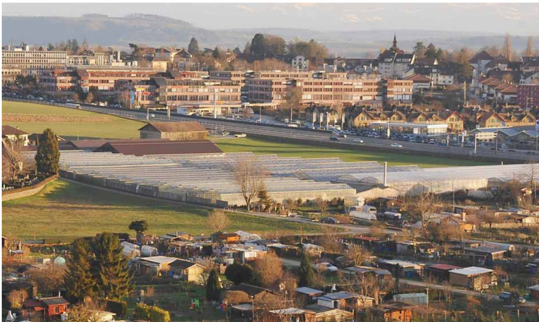
Une partie des «serres Dubied», en zone agricole, avait été transformée en locaux d'entreposage. La présence de véhicules fait craindre une pollution des sols. ARCHIVES RICHARD LEUENBERGER
