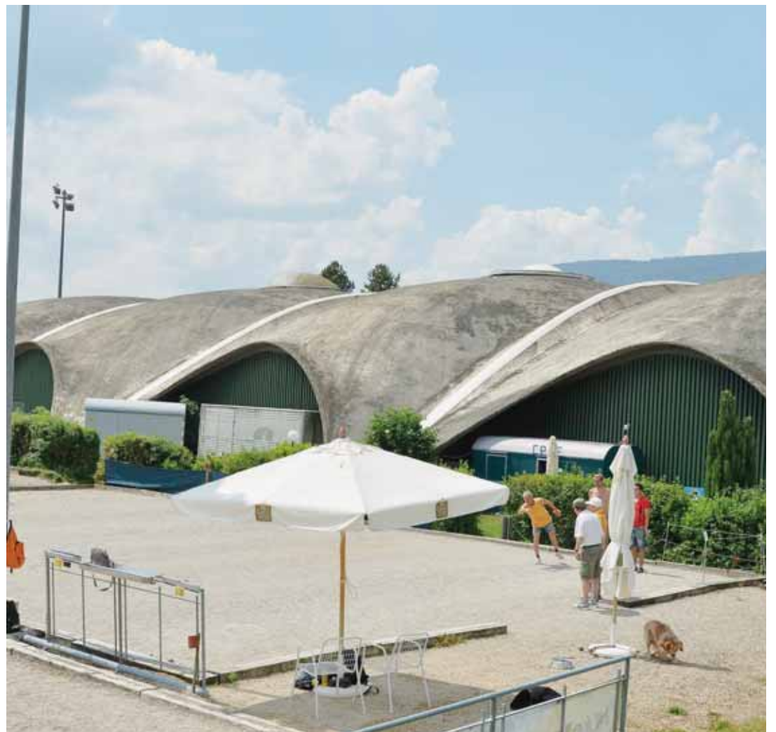
Le bâtiment multisports de La Tène affiche 30 ans d'âge. Sa toiture n'est plus étanche et les infiltrations nombreuses. RICHARD LEUENBERGER
